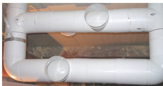
Рис. 6. Воздухораспределительный узел в процессе монтажа (вид сверху)
